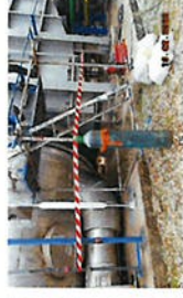
ห้ามผู้ปฏิบัติงานเชื่อมถังกับโครงสร้างโรงงาน
