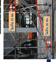
ด้านข้างสุด (Foot tie) ติดตั้งสูงไม่เกิน 15 ซม. ด้านบนต้องติดกับเสา เท่านั้นห่างจากด้านไม่เกิน 30 ซม.
